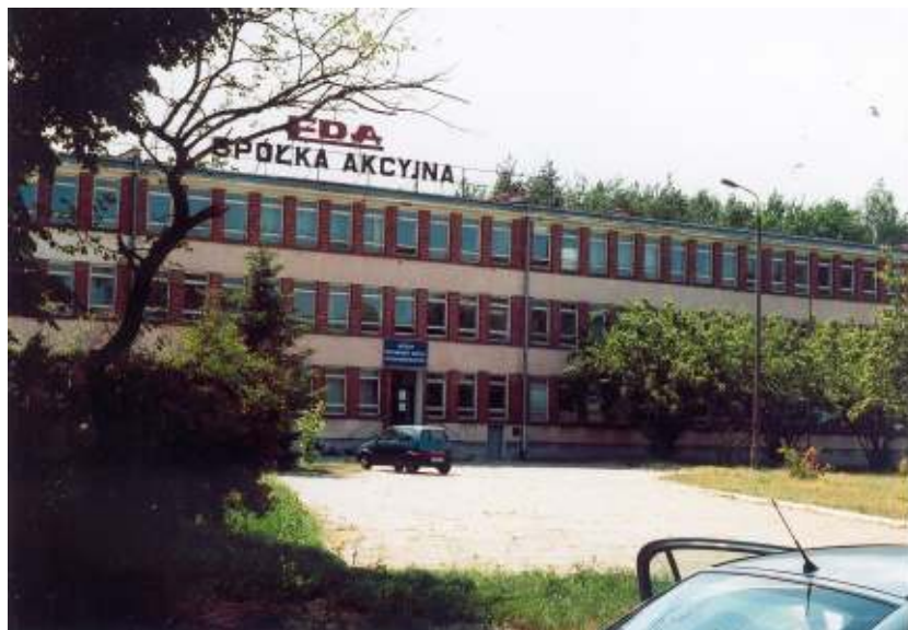
Ryc. 7. Obiekt przeznaczony na Ośrodek Leczenia, Rehabilitacji i Wybudzeń Dzieci po Urazach w Poniatowej Fig. 7. The structure intended for the Pediatric Therapeutic, Rehabilitative and Recovery Center after trauma - in Poniatowa
